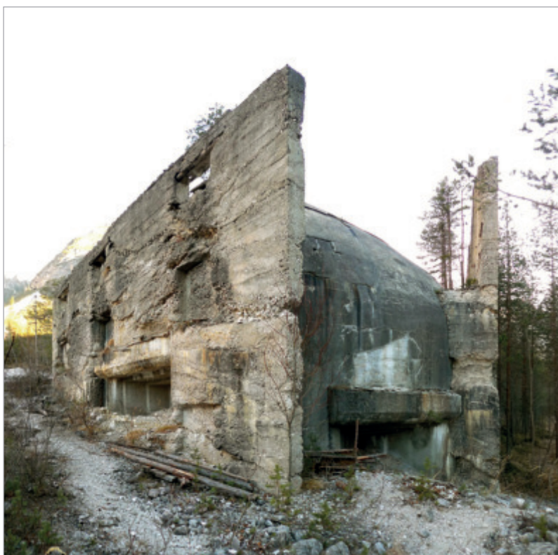
Bunkeranlagen: Die Bevölkerung wusste nicht, was gebaut wurde, doch als die Bauten Formen annahmen, wurde es für jeden offensichtlich.
